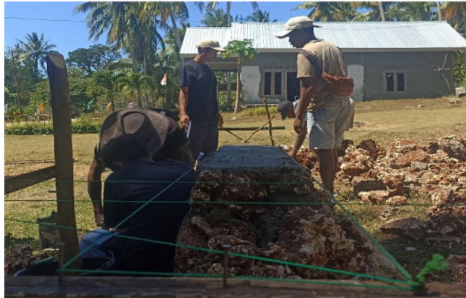
Gambar 3. Proses Pembangunan Rumah K-Poinoni [dokpri].
