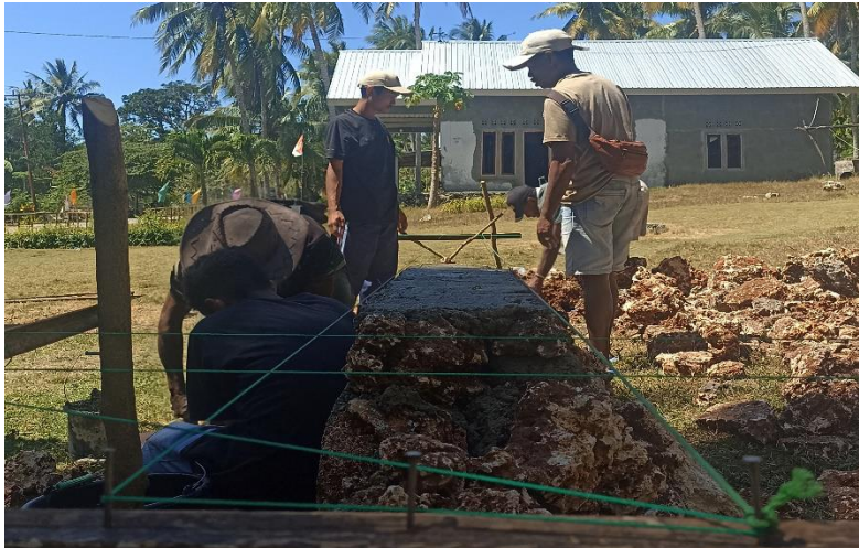
Gambar 3. Proses Pembangunan Rumah K-Poinoni [dokpri].
