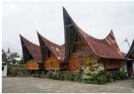
Gambar 2. Bangunan Rumah Bolon
