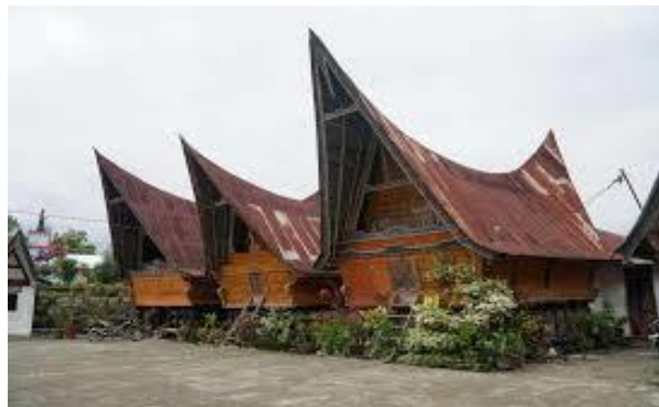
Gambar 2. Bangunan Rumah Bolon
